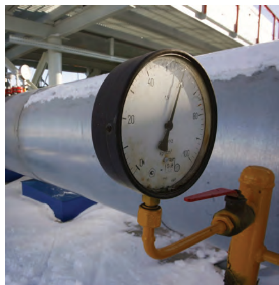
Figura 9: Particolare, il manometro segna 60 bar in questo metanodotto
